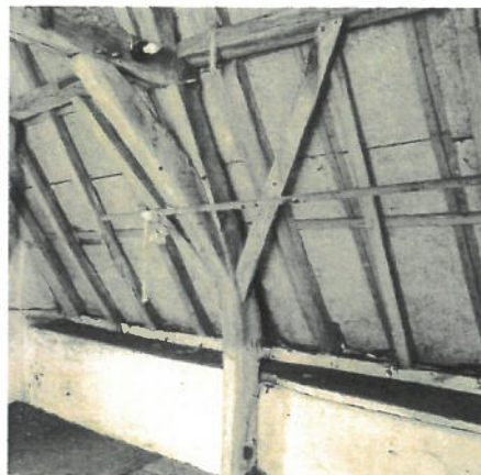
5a Detail van de kap met een dekbalkjuk van Koepoortstraat 26. Foto uit 1999. Beeldbank RCE nr. 332667
