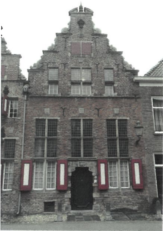
9: De gevel van het rechterpand. De gevel is niet geheel in 1649 gebouwd, maar is met behoud van delen van een oudere gevel gemoderniseerd. Het metselwerk van de topgevel is wel grotendeels in 1649 gebouwd. FH MAB 2020
