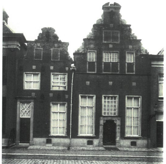
9: Koepoortstraat 29-31, voorgevels in 1926. Het bovenlicht boven de oude poort in nr. 31 is mogelijk al in de 18de eeuw gemoderniseerd met een houten kozijn en veel-ruits raam. Om de sporen van een verbouwing te maskeren is het metselwerk geverfd en voorzien van immitatievoegen. Bij de oude vensters in de topgevels zijn de bakstenen dagkanten van de vensters samen met de natuurstenen dorpels geschilderd, waardoor een houten kozijn is gesuggereerd.
