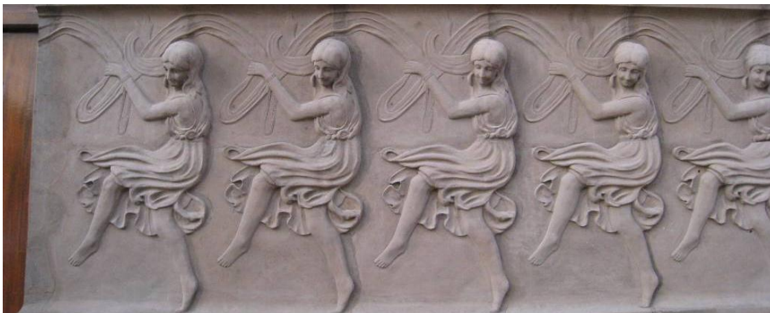
Eén van de terracottapanelen, na de reconstructie (foto auteur, april 2009)
